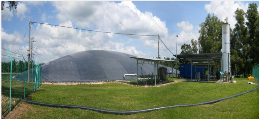
PLT Biogas dari Palm Oil Mill Effluent (POME) di PTPN V, Kebun Tandun, RIAU Biogas : 850 m 3 /hour (60% CH 4 ) Utilization : 1 MW own use
